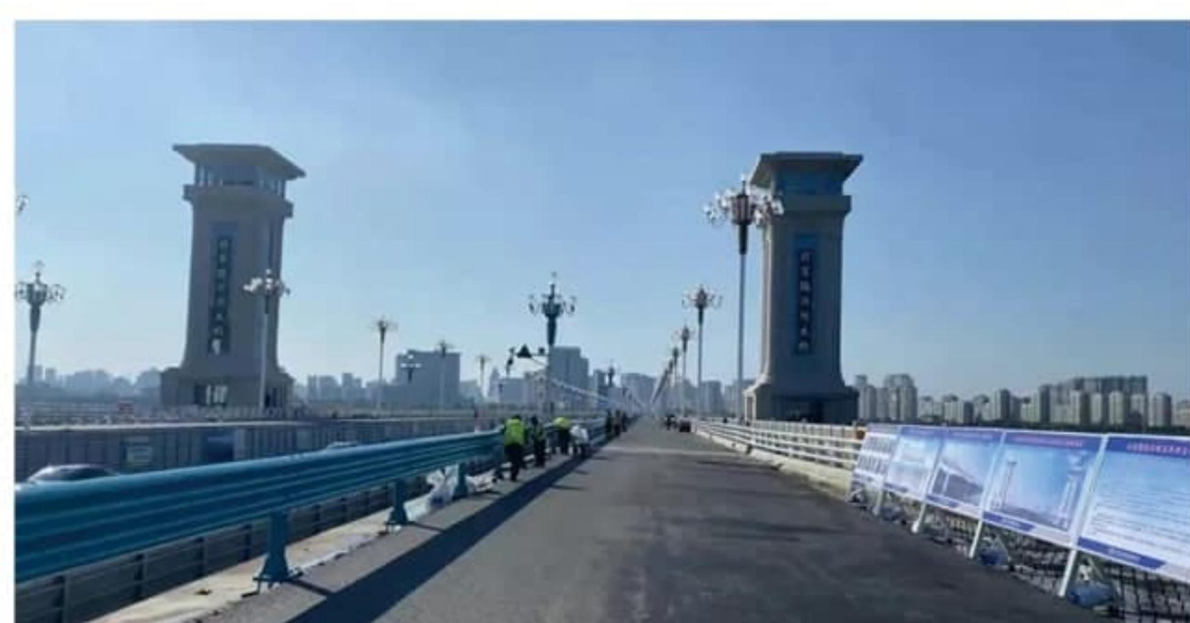
目前，北京路沂河桥新建主桥主体结构基本上已经全部完成，桥上路灯安装完成，桥面沥青路面铺设完成，新桥两侧的围栏也基本建设完成，施工人员正对桥面临时伸缩缝和临时护栏进行最后安装工作，确保北京路沂河桥新桥、老桥在国庆期间同时通行，方便市民国庆期间出行畅通，待假期结束后对老桥封闭进行桥梁顶升施工。
