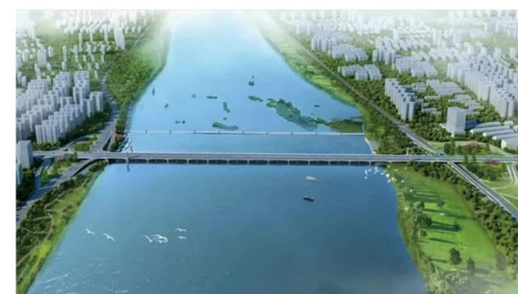
北京路沂河大桥整体外型以“中华情”为设计主题，两侧新桥采用 60 米跨径的变高度连续梁桥，桥梁墩柱融入新中式建筑风格元素，花岗岩石材雕刻，桥体及栏杆采用挑檐翼角的设计，桥上华灯延绵布置，充分体现了中国传统建筑的设计思想。
