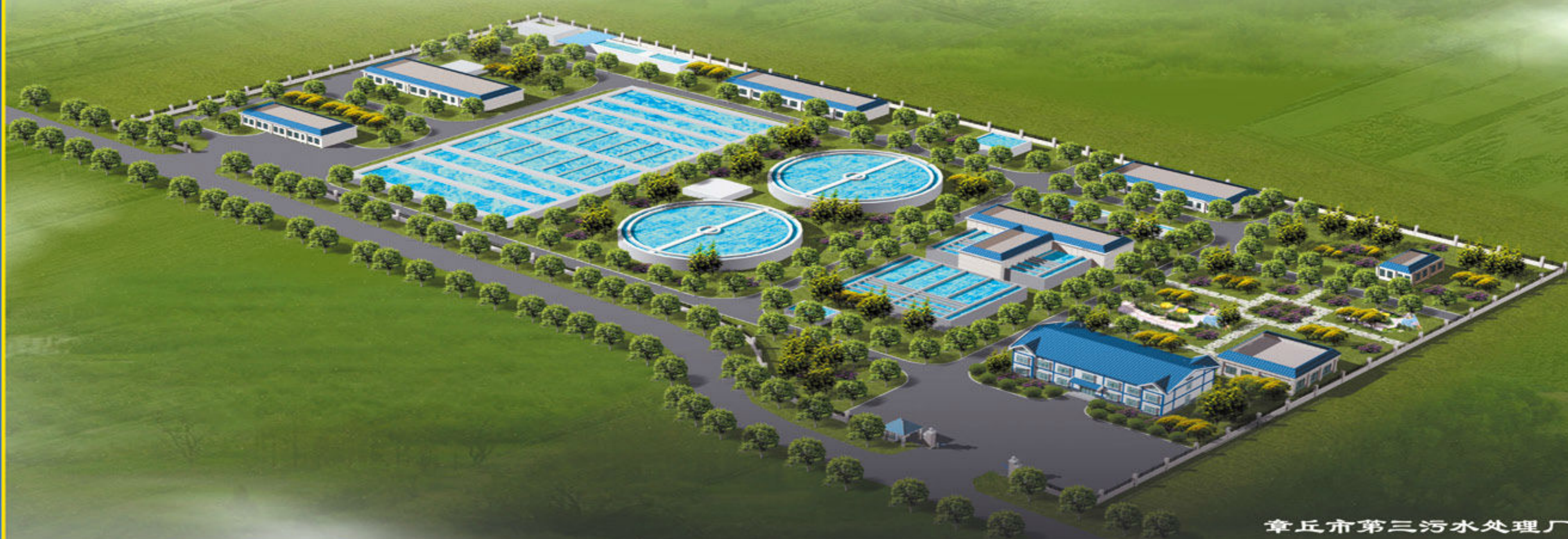
章丘市第三污水处理厂工程
